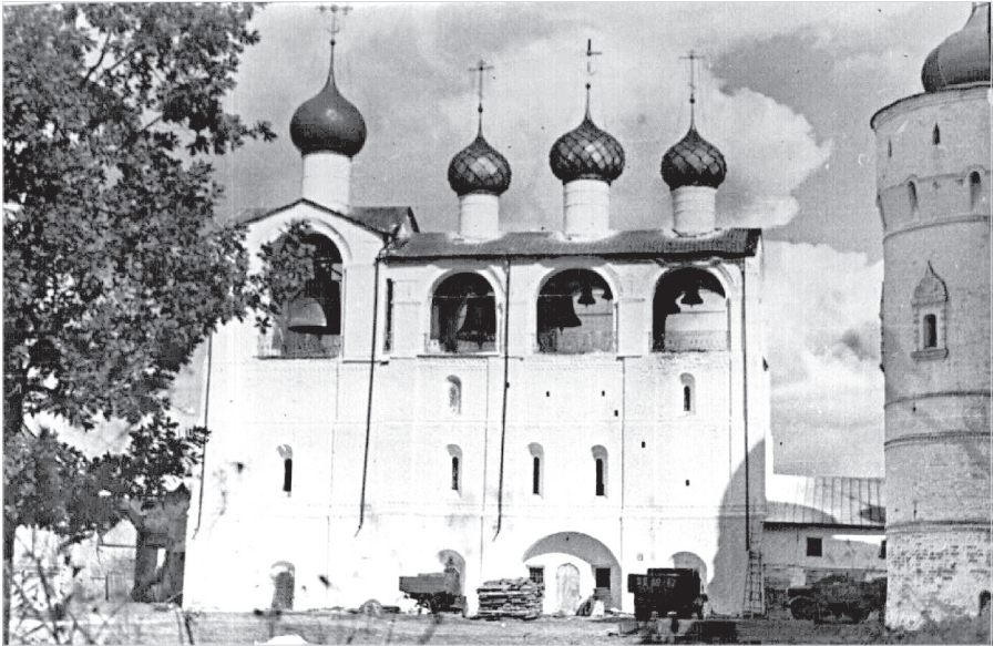
Ил. 12. Соборная звонница и Успенский собор в Ростове. Вид с запада. Фото 1951 г. ГМЗРК
