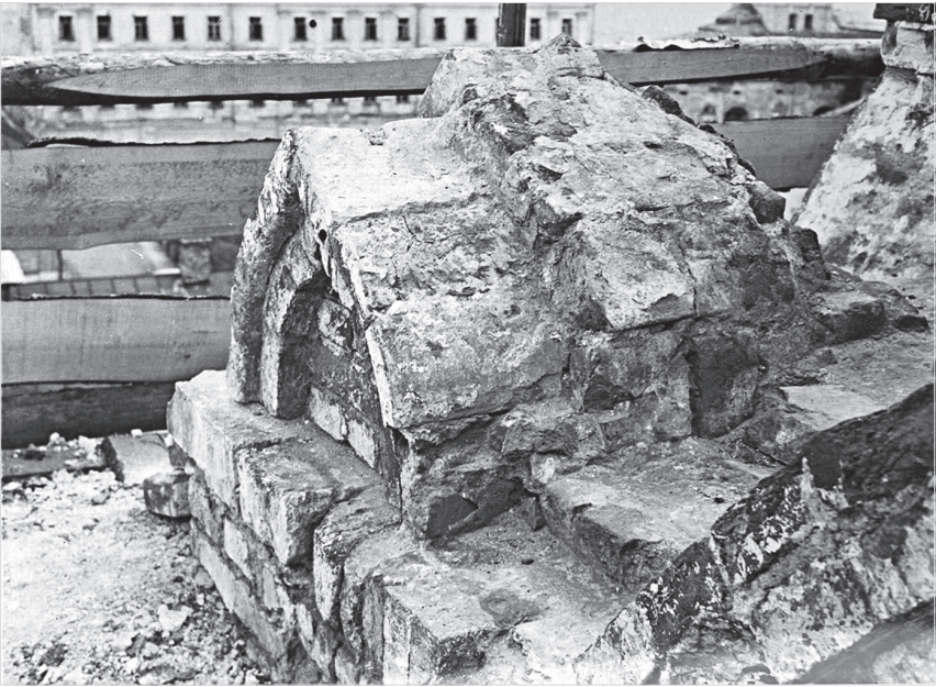
Ил. 18. Юго-восточная бочка-кокошник соборной звонницы после раскрытия. Фото 1955 г.
