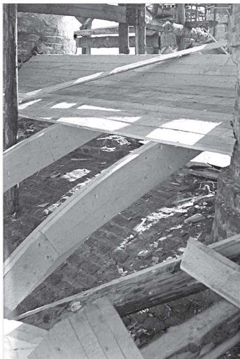
Ил. 17. Фрагмент восстанавливаемого позакомарного покрытия соборной звонницы в Ростове. Фото 1955 г.
