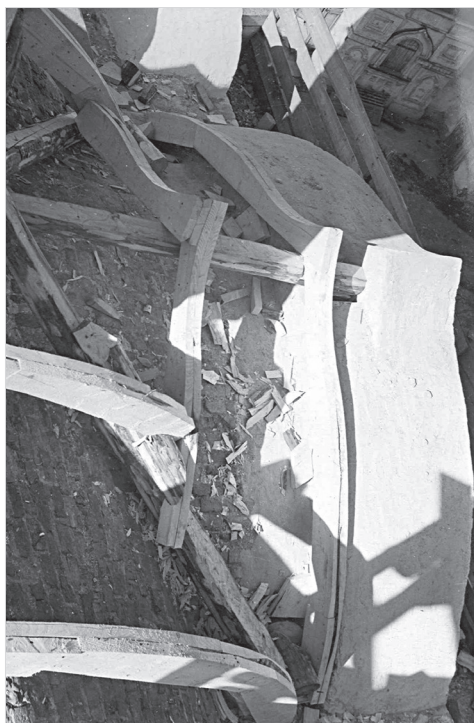
Ил. 16. Фрагмент восстанавливаемого позакомарного покрытия соборной звонницы в Ростове. Фото 1955 г.
