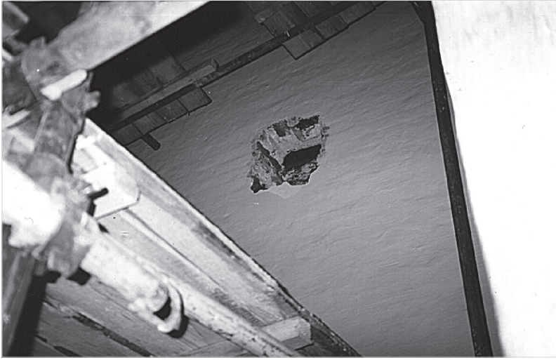
Ил. 22. Интерьер церкви Входа в Иерусалим соборной звонницы. Гнездо для балки хоров, устроенных в 2004 г. Фото 2004 г.
