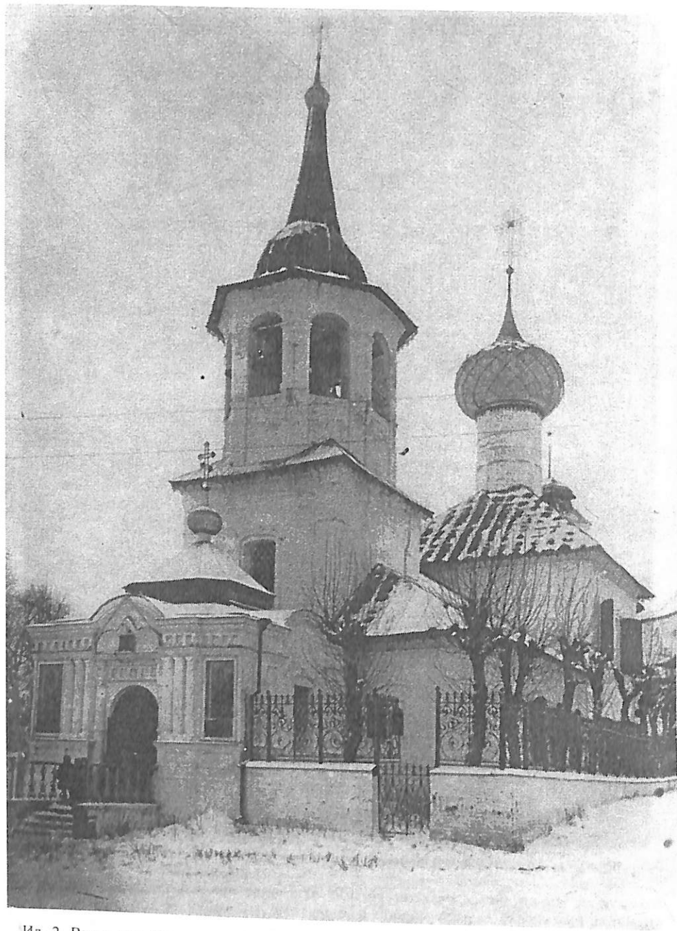
Ил. 2. Вид с юго-запада на церковь Никольскую на Подозерье (1745-1751). Фото 1920-х годов. ГМЗРК. ФТ-1136.
