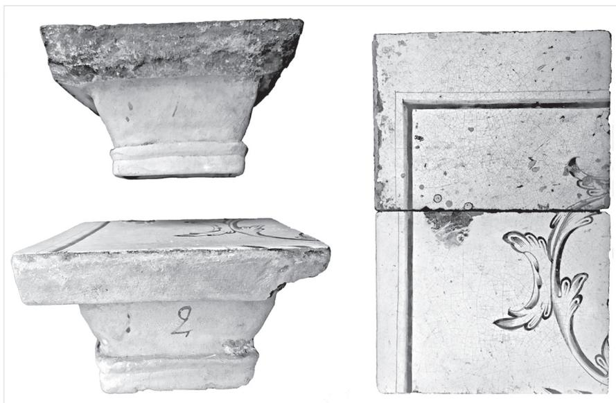
Ил. 19. Числа и метки на румпах изразцов для сбора композиции и собранный благодаря им фрагмент зеркала. Тутаев, ул. 1-я Овражная, д. 9
