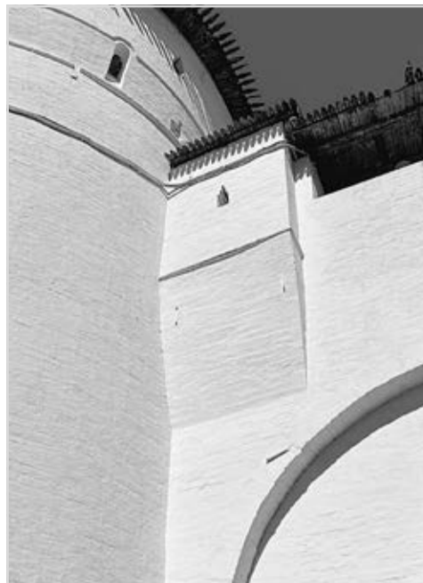
Ил. 4. Нужник, примыкающий ко второму ярусу угловой северо-восточной башни Ростовского кремля
