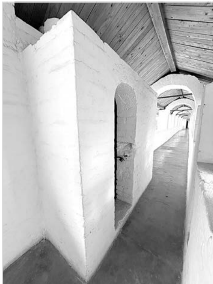
Ил. 1. Нужник на переходе северного прясла западной крепостной стены Ростовского кремля
