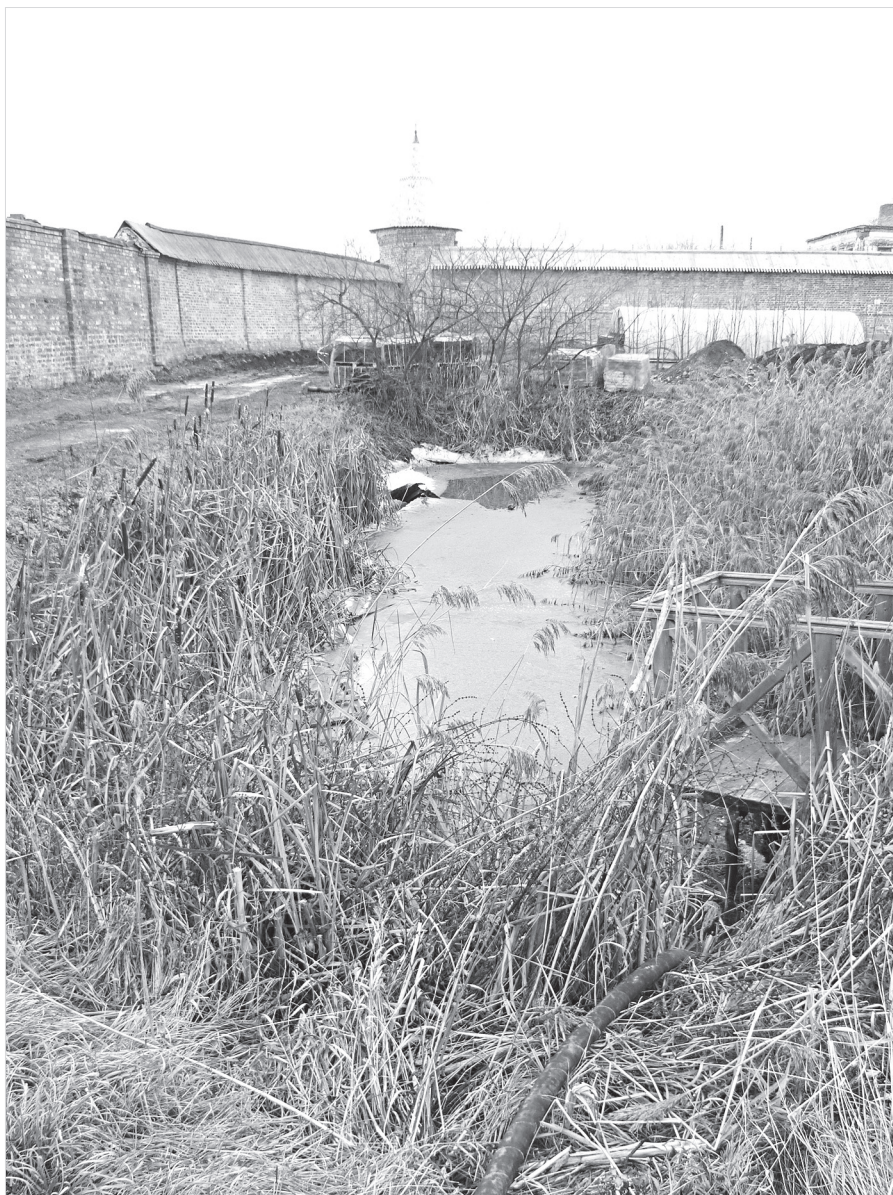
Ил. 15. Вид на садовый пруд с восточной стороны перед началом работ по очистке. ГМЗРК. Фотография из архива сектора мониторинга. Ноябрь 2011 г.
