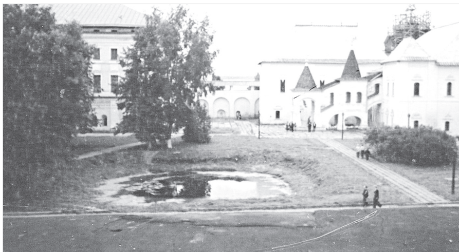
Ил. 12. Вид на центральный пруд с западного прясла северной стены до снятия грунта. ГМЗРК. Фотография из архива сектора мониторинга. Лето 1997 г.
