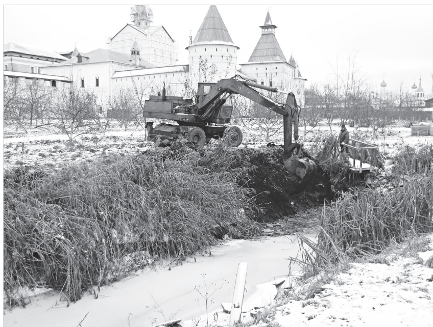
Ил. 16. Вид на садовый пруд с юго-западной стороны. Очистка, углубление дна и расширение водоема. ГМЗРК. Фотография из архива сектора мониторинга. Ноябрь 2011 г.
