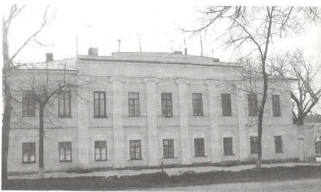
Илл. 2. Здание Титовской богадельни. 1838. Фото 2008.
