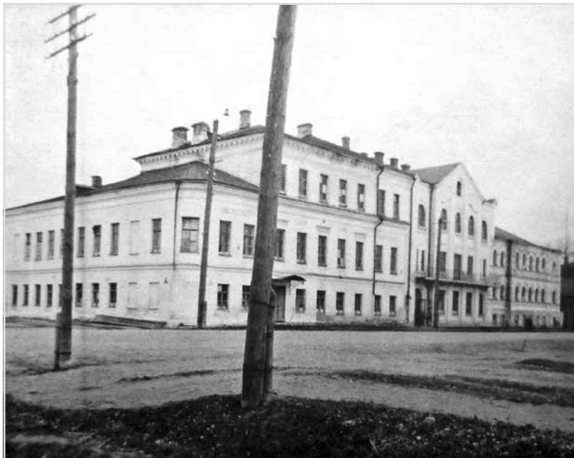
Ил. 2. Главный корпус больницы, вид с юго-западной стороны, ок. 1949 г. Семейный архив К.А. Степанова
