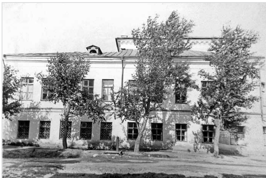
Ил. 3. Главный корпус больницы, вид с западной стороны. Начало 1960-х гг. РФ ГАЯО. Ф. Р-1281. Оп. 1. Д. 9. Л. 22
