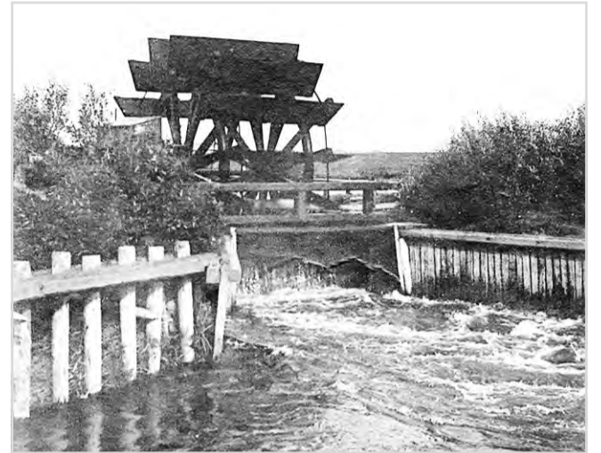
Ил. 3. Водяное колесо с лопастями на плотине р. Устье, вид с юго-востока. Фото 1909 г.
