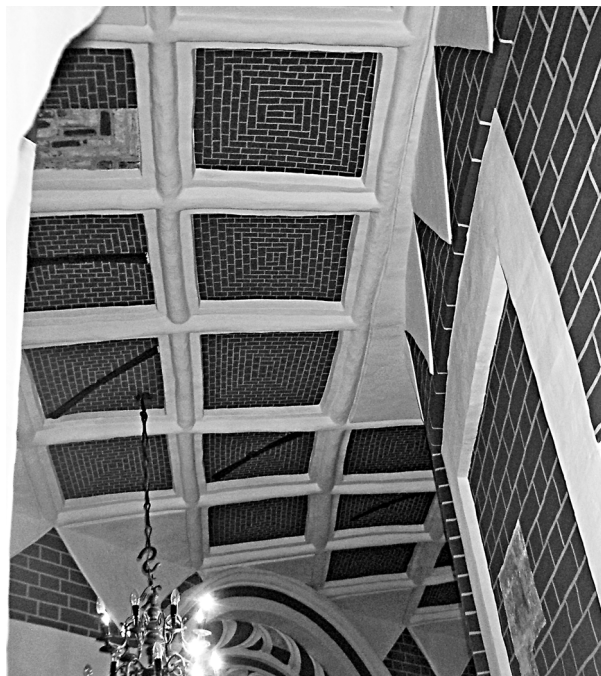
Ил. 5. Фрагмент горизонтального перекрытия собора Покрова на Рву в Москве
