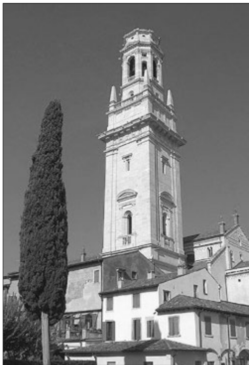
Колокольня Кафедрального собора Санта-Мария-Ассунта (основание XII–XIII в., средняя часть XVI в., архитектор Микеле Санмикели, верхняя часть (не завершена) нач. XX в., архитектор Этторе Фаджуоли). Высота 75 м. Фото Маттео Падовани
